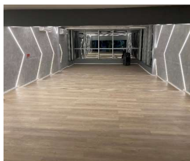
Reforma e ampliação da Sala de Spinning
