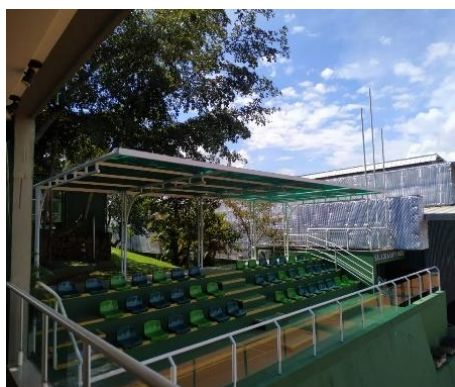
Cobertura da arquibancada do tênis
