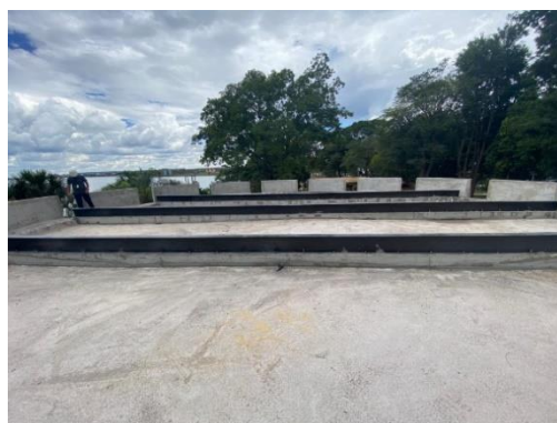
Reforço Estrutural Cobertura Antiga Sauna
