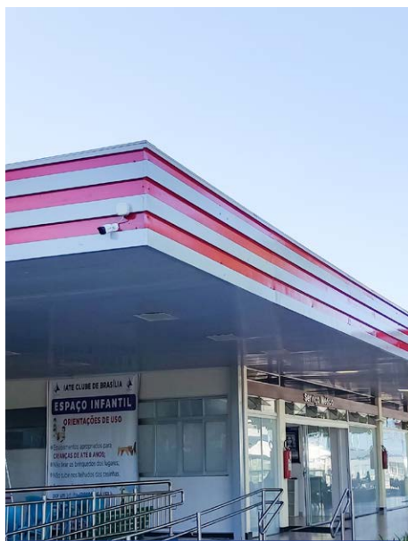
Pintura das faixas horizontais superiores do late Shopping e Ciате
