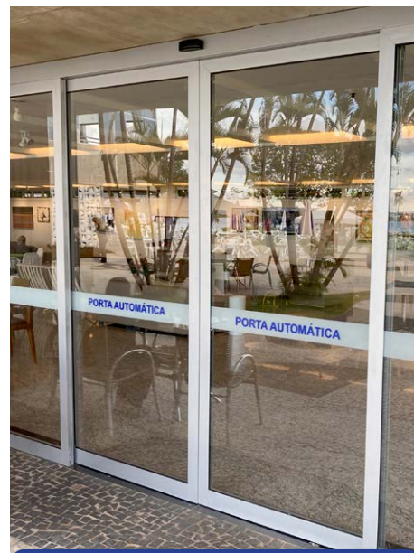
Instalação de portas elétricas e mecânicas no late TV
