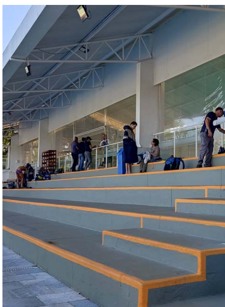
Revitalização e pintura da arquibancada e da cobertura da piscina semiolímpica
