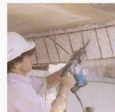
Figura 1 – escarificação do concreto danificado
